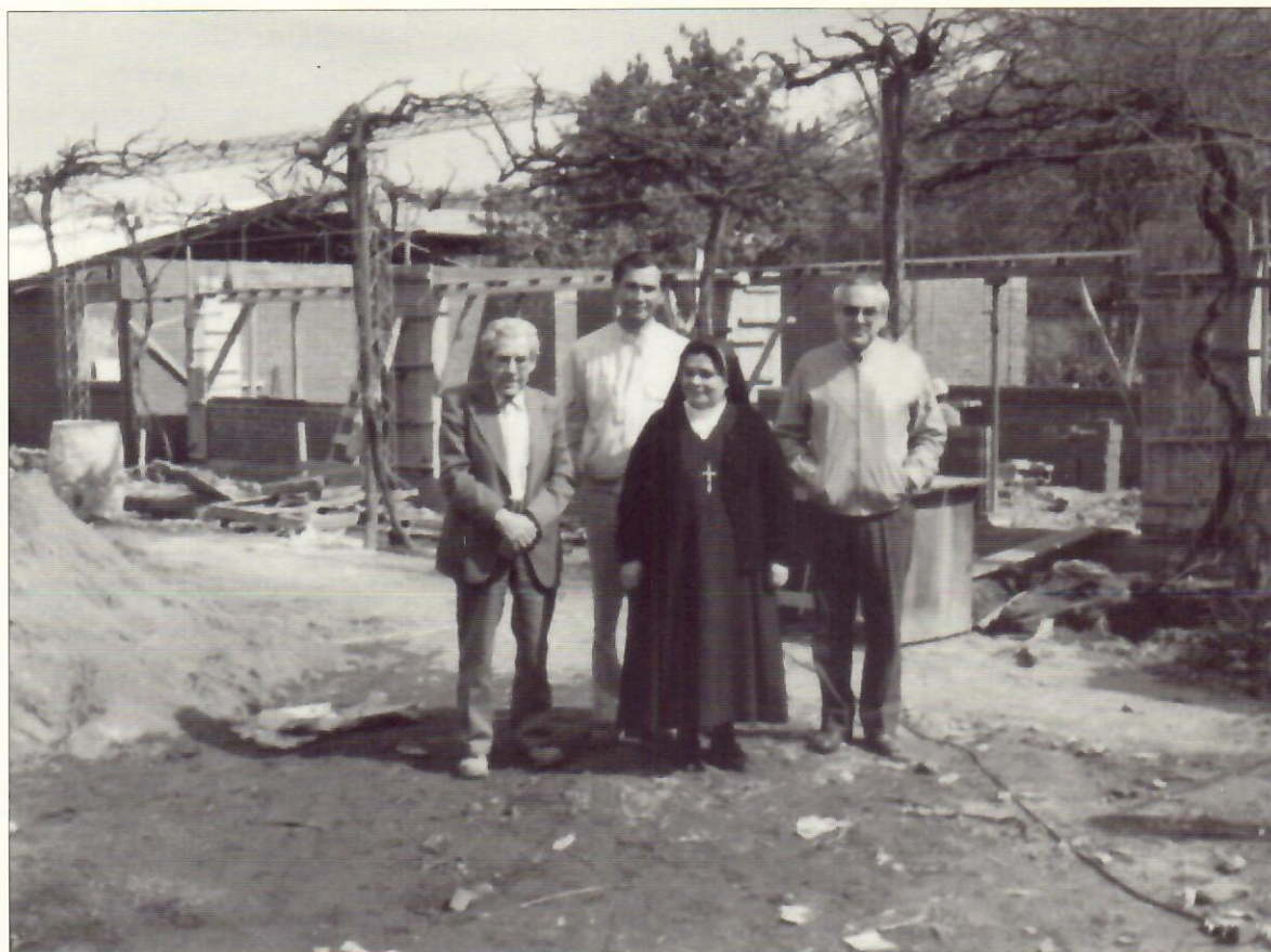
Broeder Tatianus (links) met moeder overste, architect en aannemer voor het nieuwe klooster in aanbouw. Het dak zit al op de kamers van de zusters.
